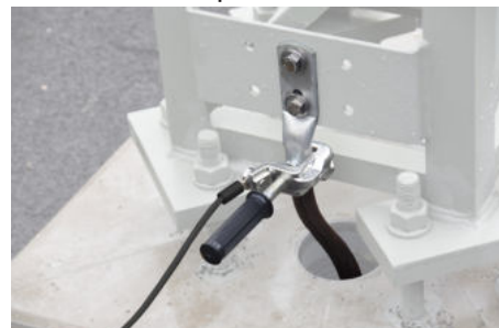
Erdverbindung mit Universalklemme
