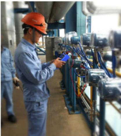
Die Anforderungen von Fernkalibrierungsarbeiten können eine Herausforderung sein. Die ADT226-Serie ist leicht und äußerst tragbar und verfügt über ein fortschrittliches Farb-LCD-Display, um sicherzustellen, dass Sie leicht sehen können, sogar in den (Ex) eigensicheren Versionen.
