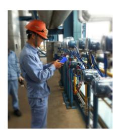
Die Anforderungen von Fernkalibrierungsarbeiten können eine Herausforderung sein. Die ADT227-Serie ist leicht und äußerst tragbar und verfügt über ein fortschrittliches Farb-LCD-Display, um sicherzustellen, dass Sie leicht sehen können, sogar in den (Ex) eigensicheren Versionen.
