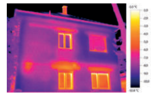
Wärmebild mit testo ScaleAssist
