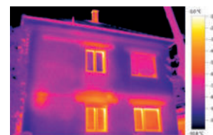
Wärmebild mit testo ScaleAssist
